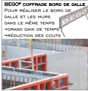
TECHNIQUE COFFRAGE BORD DE DALLE
