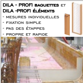
COFFRAGE POUR JOINT DE DILATATION
