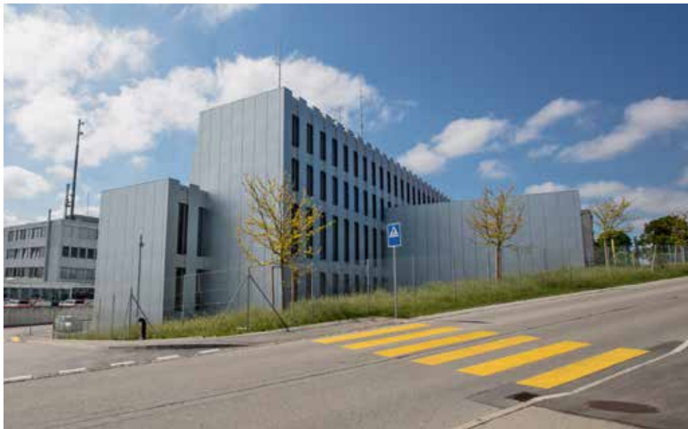
Une structure entièrement en bois et une peau toute de métal (aluminium éloxé): un duo gagnant, tant du point de vue de la durabilité que sur le plan de l'image institutionnelle.
