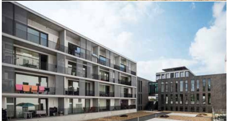
La mixité de l'îlot est soulignée par un traitement différent des façades, notamment avec des matériaux contrastants, verre, métal et briques.
