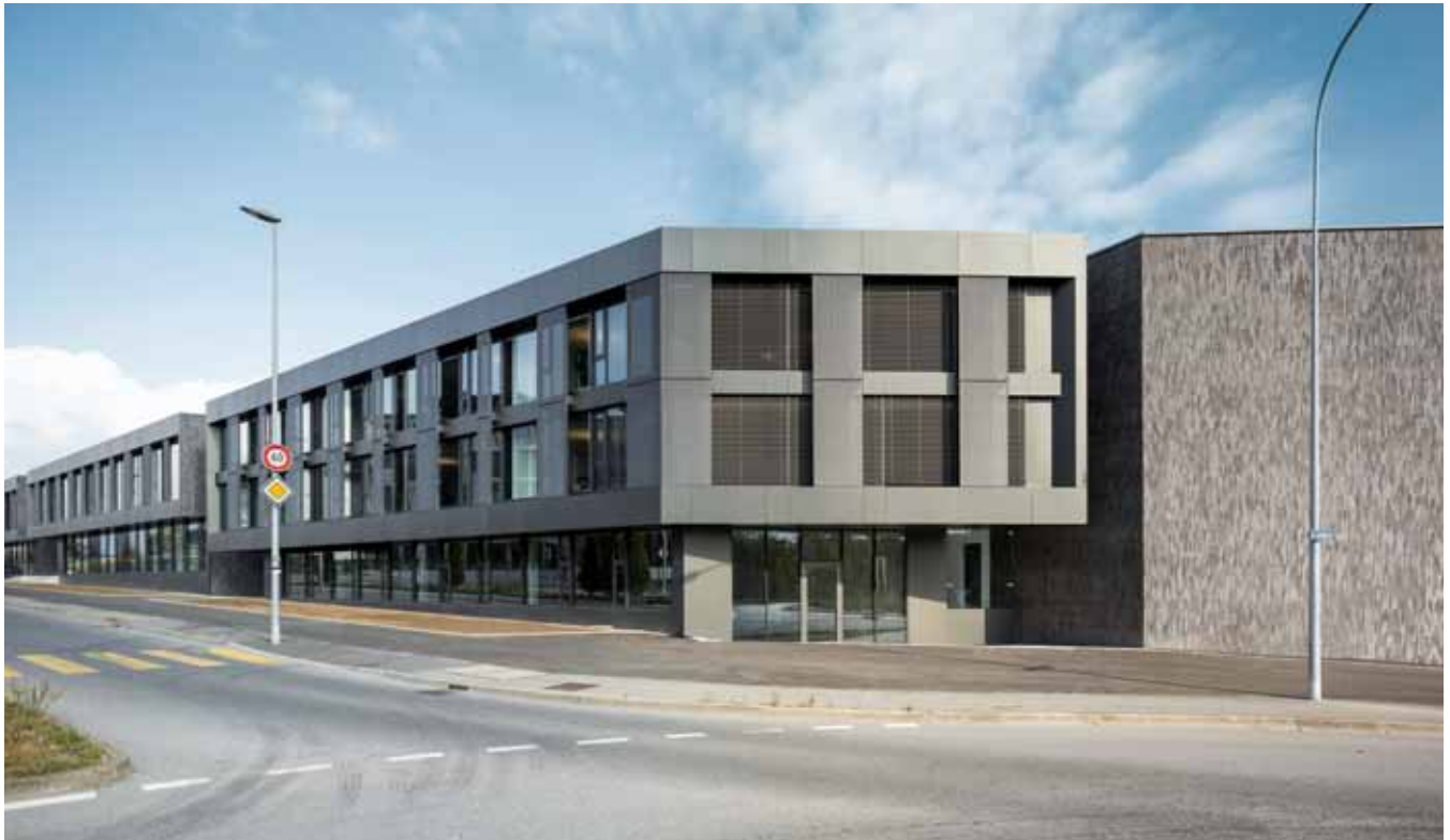
Côté route, le bâtiment d'activité fait écran au bruit. Derrière, les habitations forment un «peigne» de trois immeubles.
